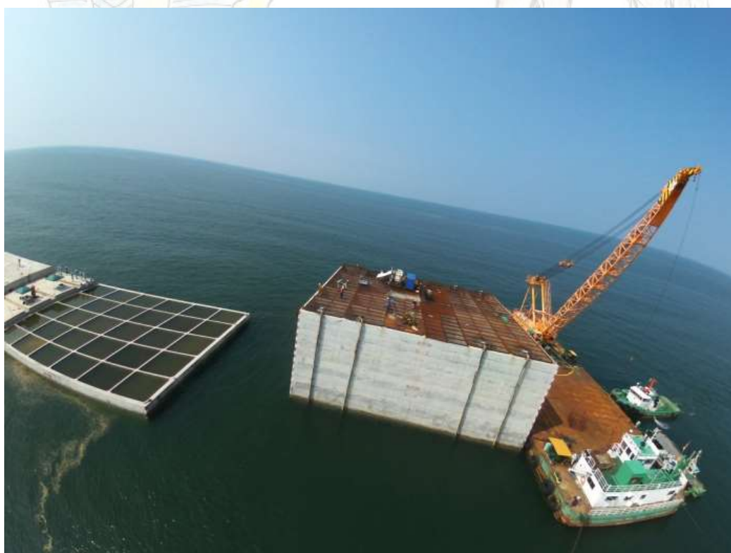
沉箱設置灌水沈設圖
